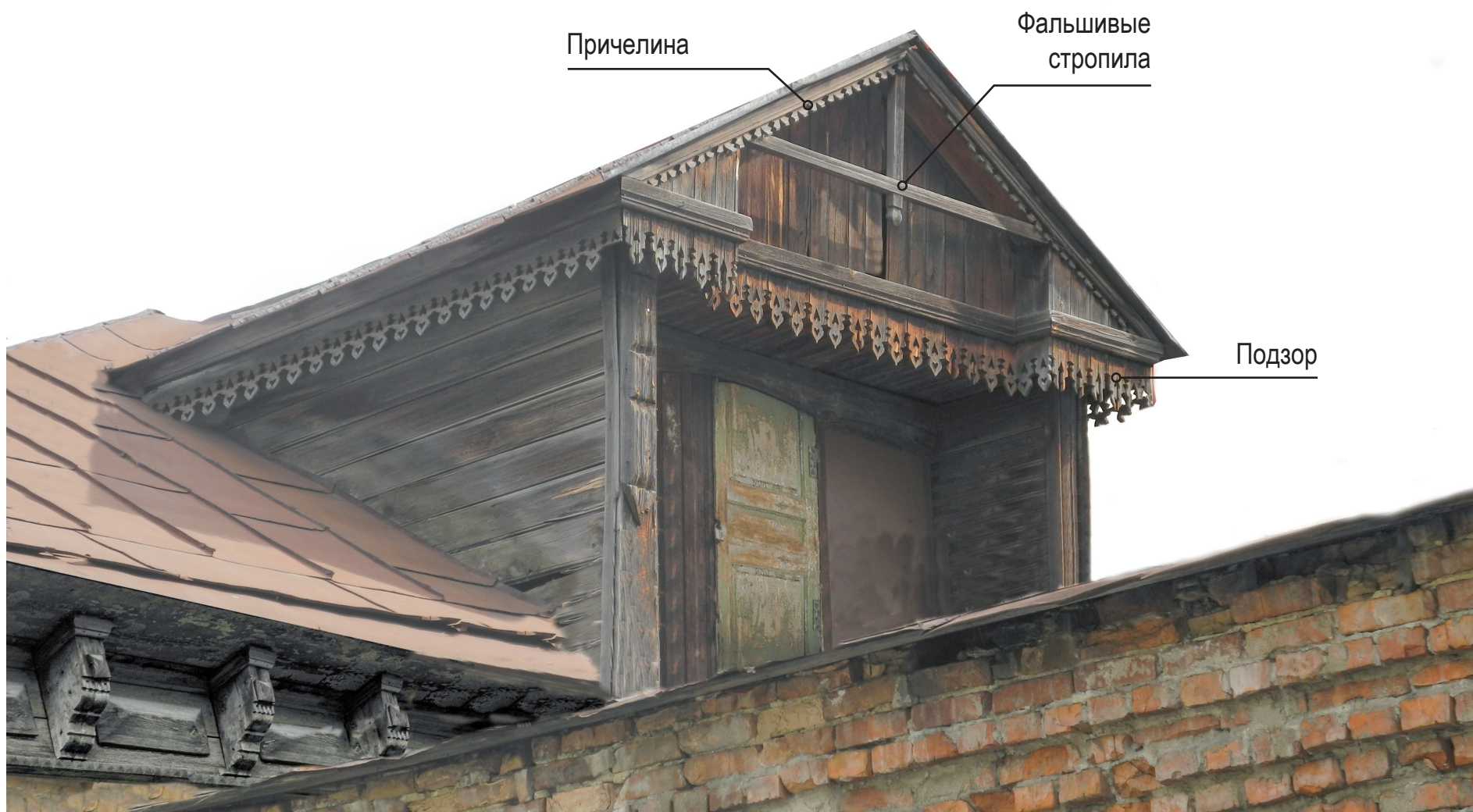
Чердачное помещение (вид с запада)
